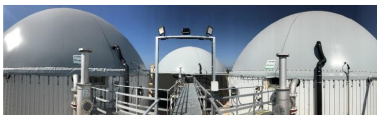
Fotografia 3.9 - Reatores, plataforma e válvulas de sobrepressão numa unidade existente.
