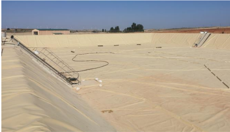
Fotografia 3.6 - Exemplo de construção de uma lagoa de armazenamento de digerido.
