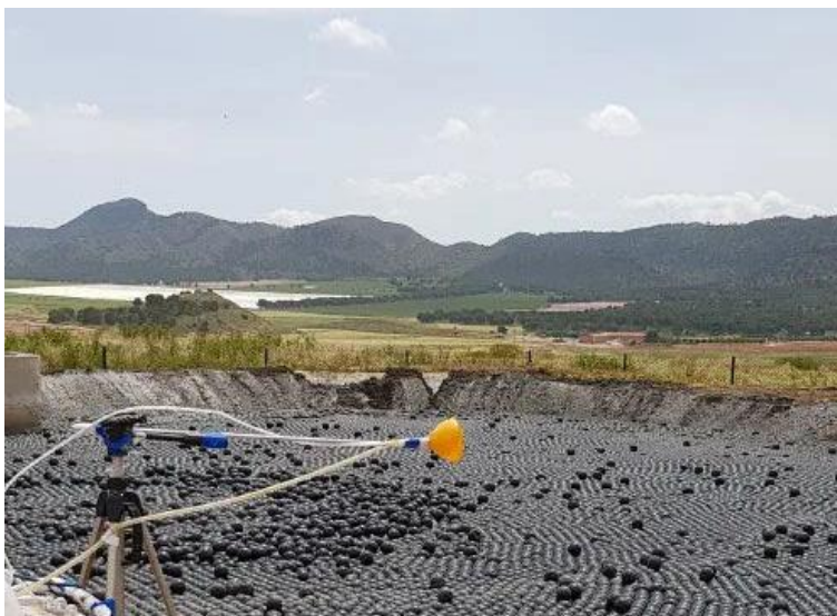
Fotografia 3.7 - Exemplo de cobertura da lagoa de armazenamento do digerido.
